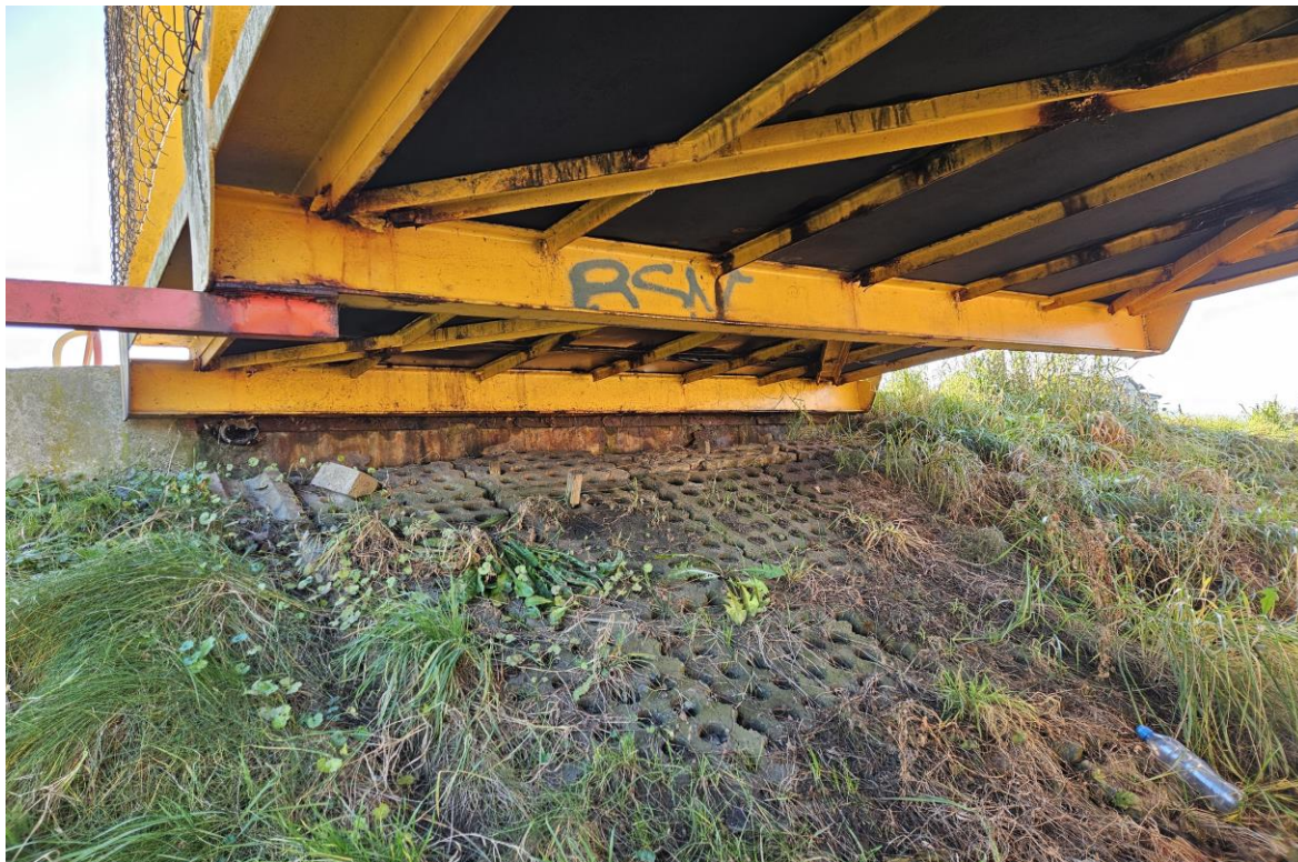
Uszkodzenia odwodnienia liniowego – brak kolanek, ścieki skarpowe zanieczyszczone, utrudniające odpływ wody opadowe
