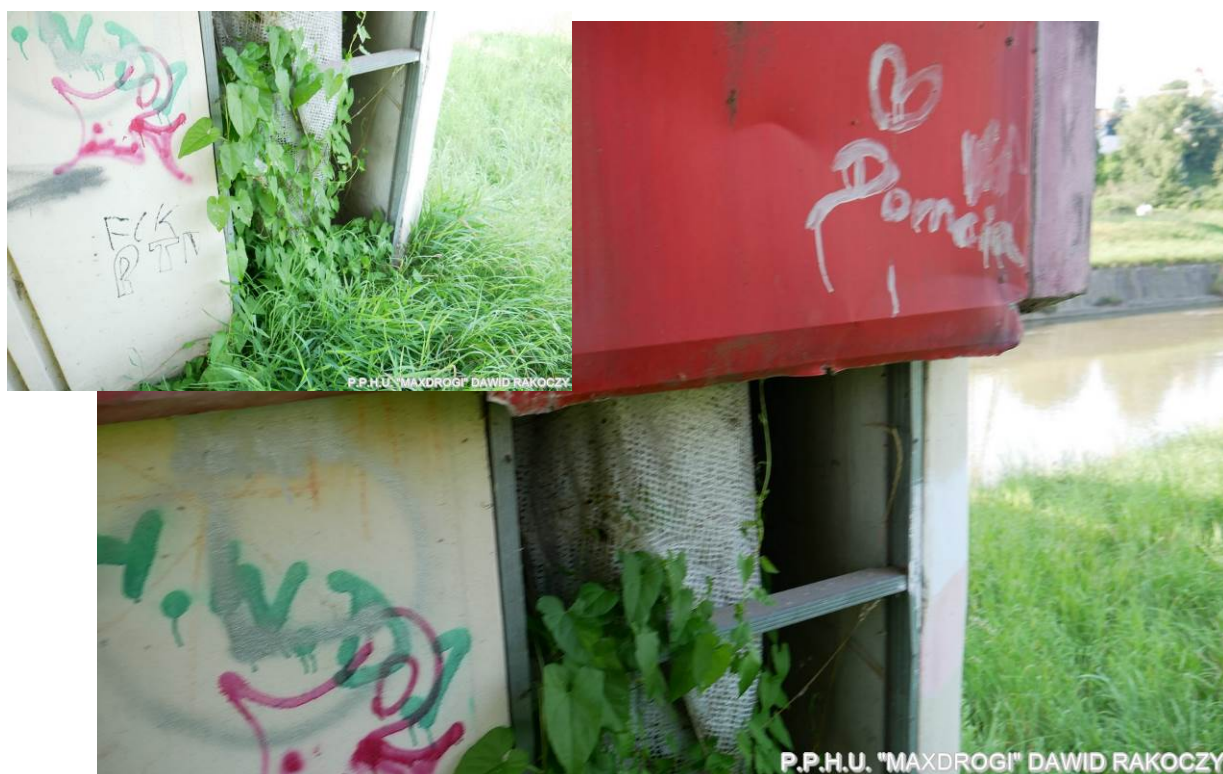
Fot. 16. Lokalny brak osłon stalowych dla sieci urządzeń obcych na korpusie filara południowego
