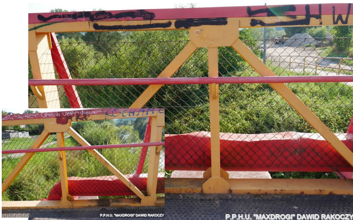
Fot. 7. Lokalne niszczenie zabezpieczeń antykorozyjnych i ogniska korozji na powierzchni stalowych balustrad wraz z nieestetycznym „graffiti”
