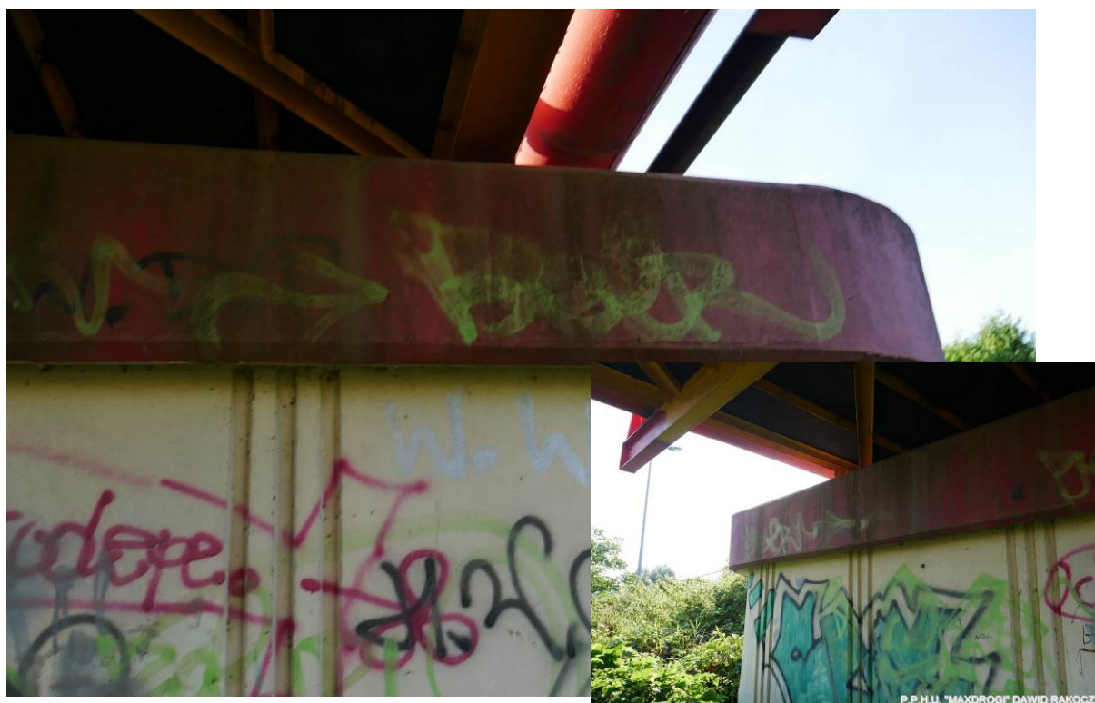
Fot. 15. Filar podporowy od strony północnej wykazuje zacieki, co jest efektem braku szczelności pomiędzy płytami pomostu, a nieestetyczne „graffiti” na jego powierzchni obniża ocenę estetyki obiektu
