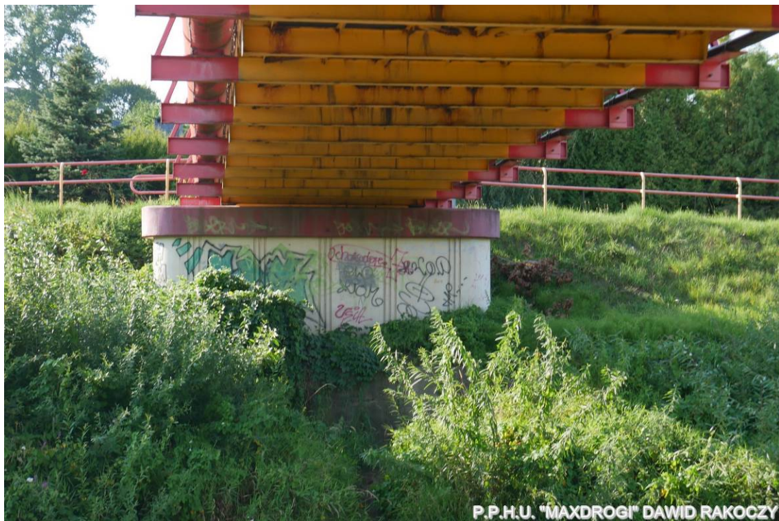
Fot. 5. Skarpy rzeki w obrębie podpór porośnięte bujną nieskoszoną roślinnością. Pod obiektem postarają krzewy. Widok w kierunku skarpy północnej
