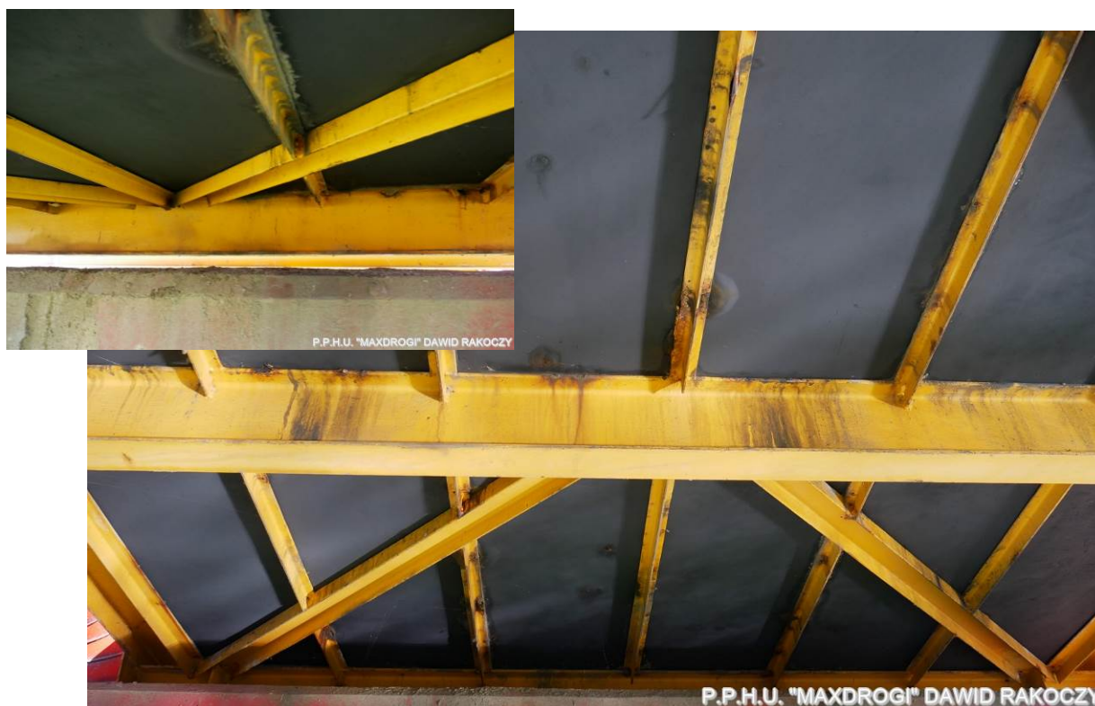
Fot. 10. Zacieki na stalowej konstrukcji poprzecznic pod płytą pomostową świadczą o braku szczelności na połączeniu poszczególnych segmentów płyt. Penetracją woda prowadzi do niszczenia zabezpieczeń antykorozyjnych i korozji stalowych elementów ustroju nośnego, poprzecznic i stężeń
