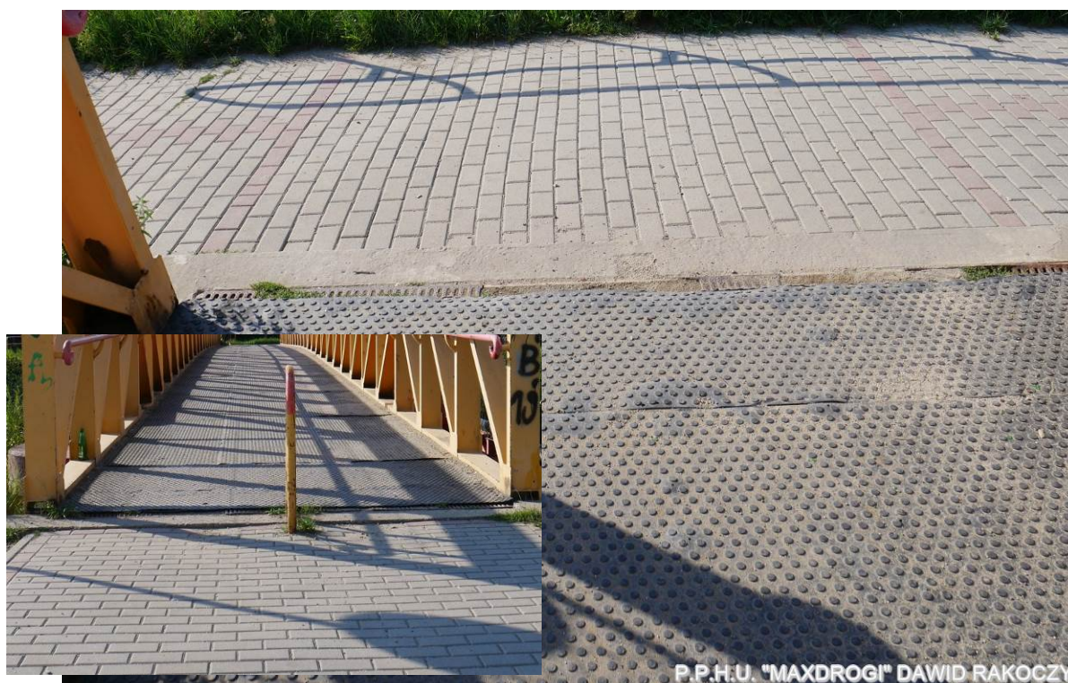
Fot. 8. Korytka odwodnienia liniowego na obydwu końcach kładki całkowicie zanieczyszczone i niedrożne, w których porasta roślinność, lokalnie brak krutek zabezpieczających stanowi zagrożenie bezpieczeństwa ruchu pieszych
