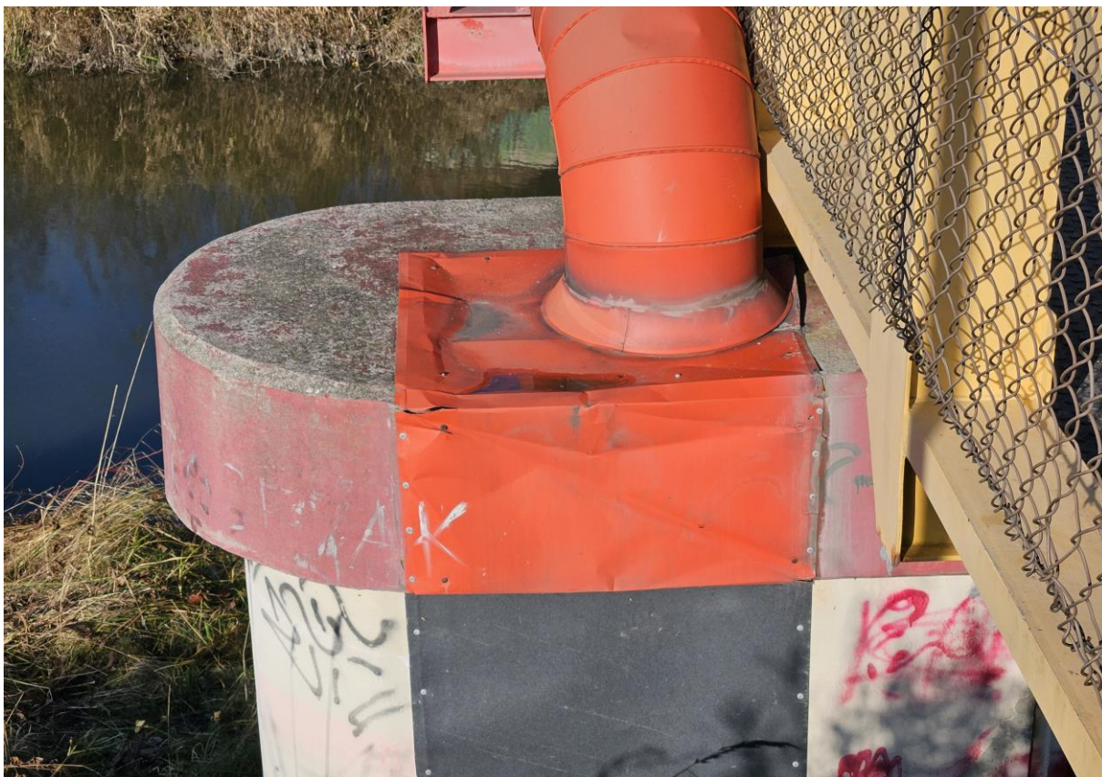
Uszkodzone osłony ciepłociągów od strony południowej
