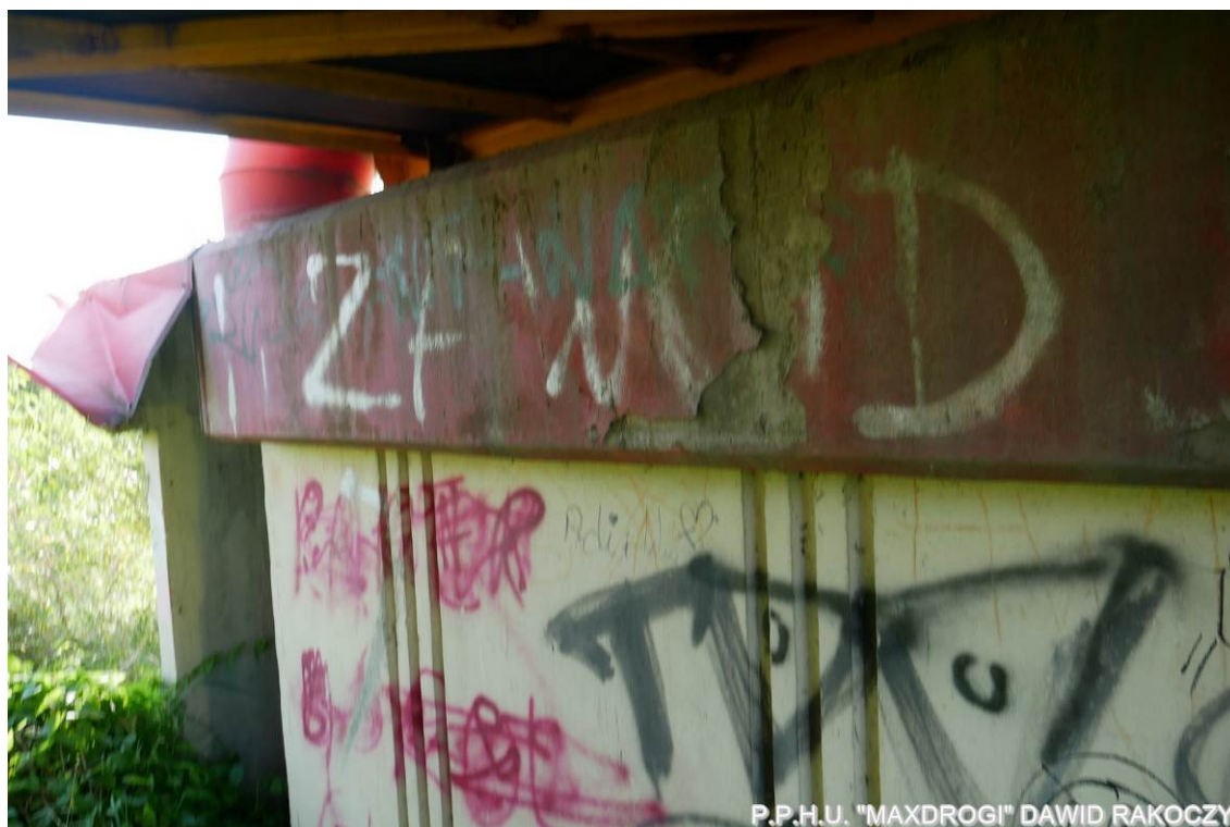
Fot. 14. Filar podporowy od strony południowej wykazuje erozję powierzchniową zwieńczenia betonowego, powłoki malarskie i beton łuszczy się, co jest efektem braku szczelności pomiędzy płytami pomostu, a nieestetyczne „graffiti” na jego powierzchni obniża ocenę estetyki obiektu
