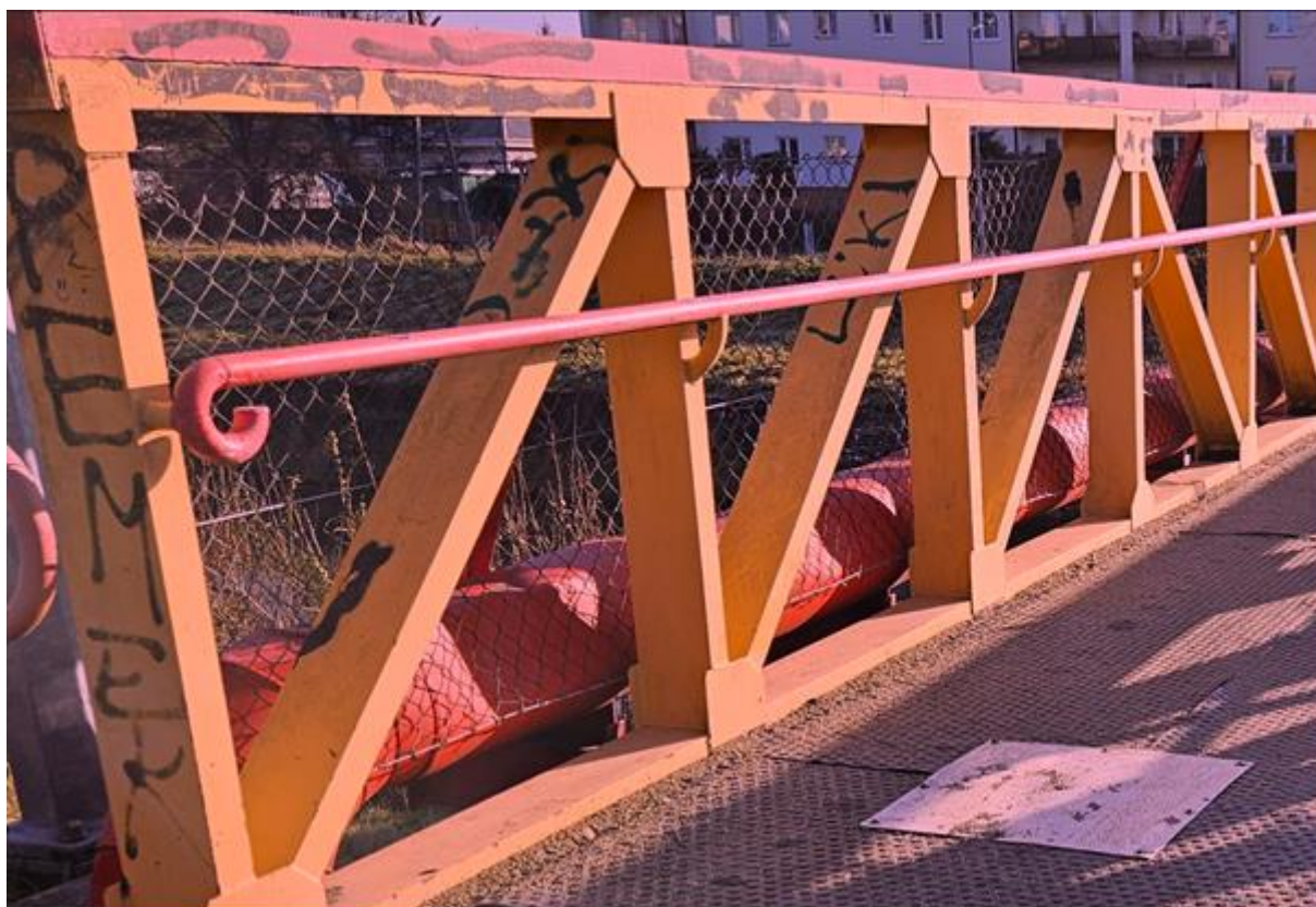
Lokalne niszczenie zabezpieczeń antykorozyjnych na powierzchniach balustrad wraz z graffiti obniżającym estetykę obiektu
