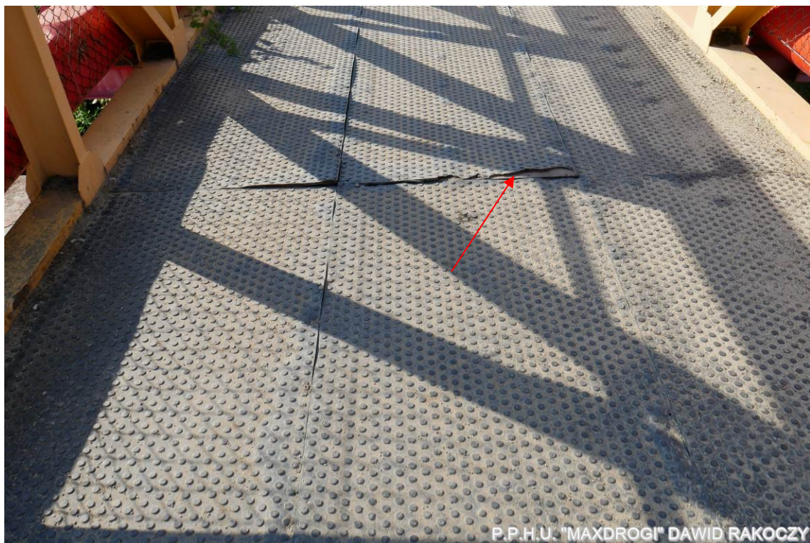
Fot. 6. Gumowa nawierzchnia na kładce ulega lokalnym uszkodzeniom, tj, krawędzie płyt gumowych deformują się i ulegają wykruszeniu, co zagraża bezpieczeństwu ruchu publicznego. Na krawędziach nawierzchni chodnika zalegają zanieczyszczenia piaskowe
