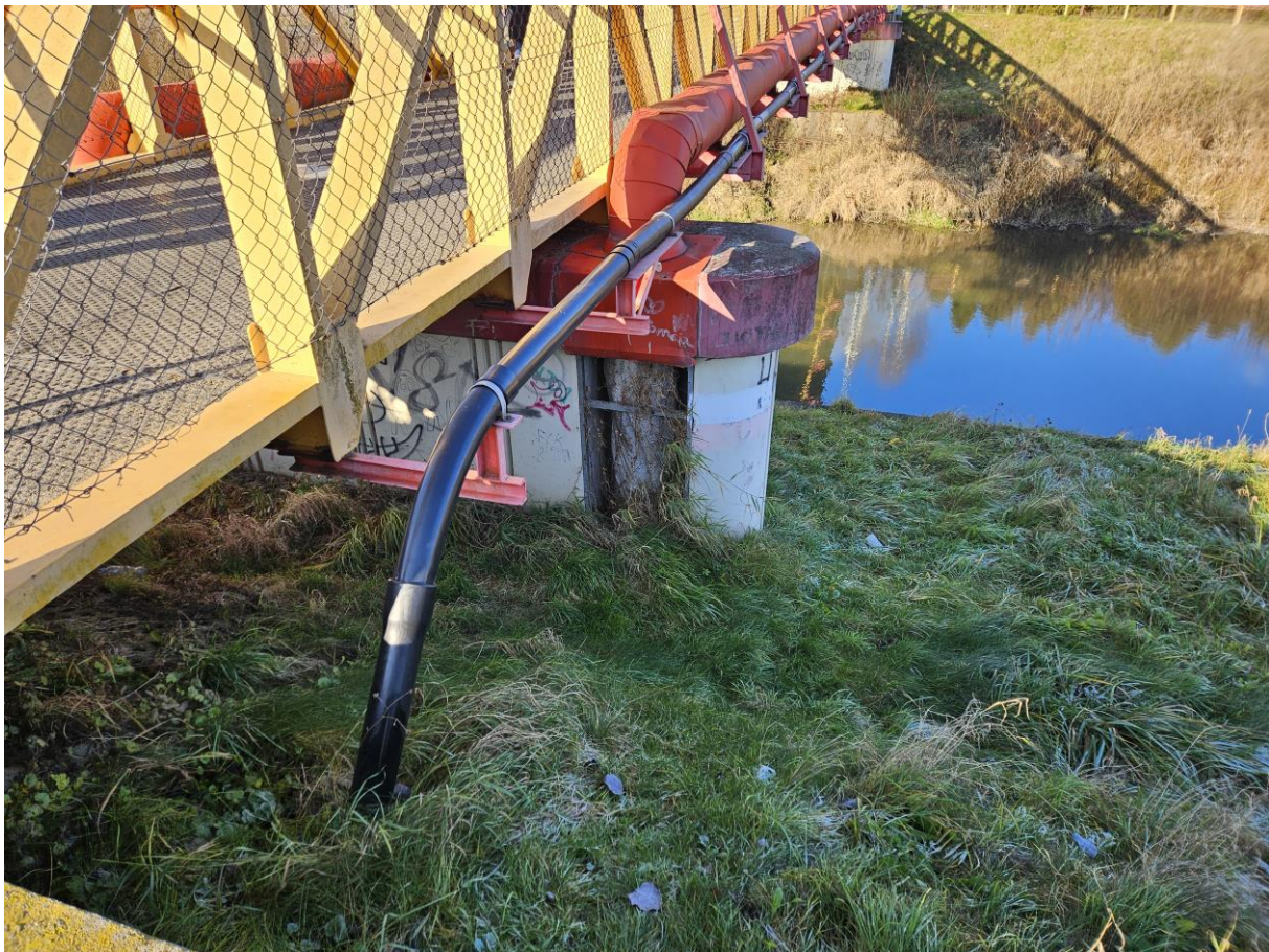
Brak osłon ciepłociągu idąc w kierunku ul. Blich
