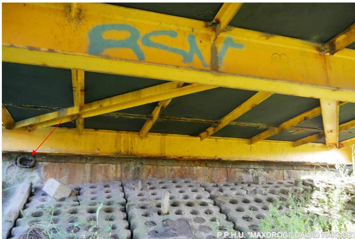
Fot. 9. Brak kolanek wylotowych rur spustowych z odwodnienia liniowego na ścieki skarpowe. Ścieki skarpowe zanieczyszczone, utrudniające spływ wody opadowej
