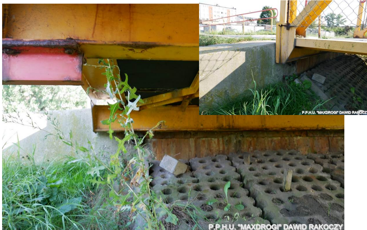
Fot. 13. Zacieki na powierzchni przyczółka świadczą o braku szczelności dylatacji. Przyczółki pokryte glonami, co przyczynia się do przyspieszonej degradacji betonu
