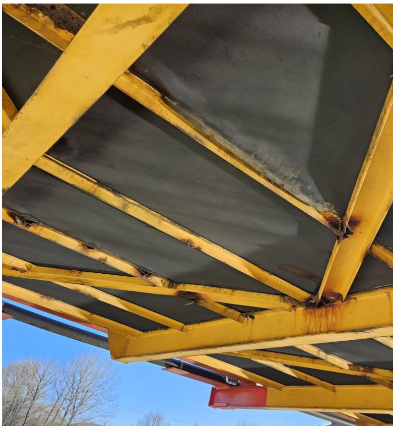
Zacieki na stalowej konstrukcji świadczące o nieszczelności pomiędzy segmentami płyt pomostu
