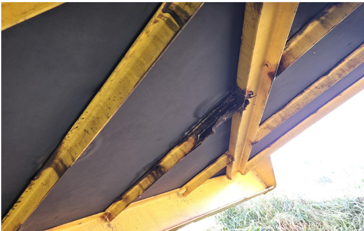
Obszerna korozja świadcząca o uszkodzeniu powłoki antykorozyjnej dźwigarów, poprzecznic, stężeń i podłużnic
