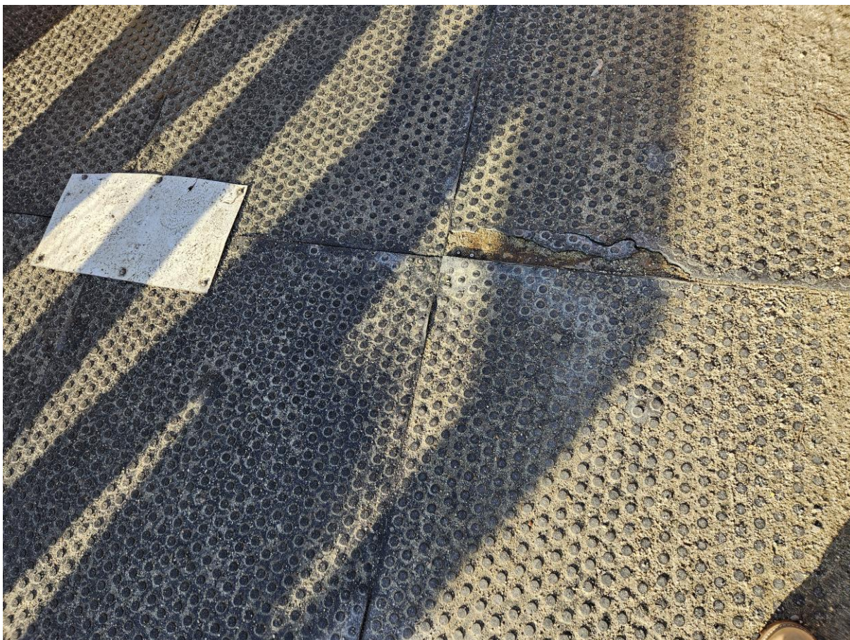
Gumowa nawierzchnia na kładce ulega uszkodzeniom na krawędziach płyt pomostu, co sprzyja zaleganiu zanieczyszczeń w obrębie styku płyt, skutkuje to przyspieszeniem korozji elementów
