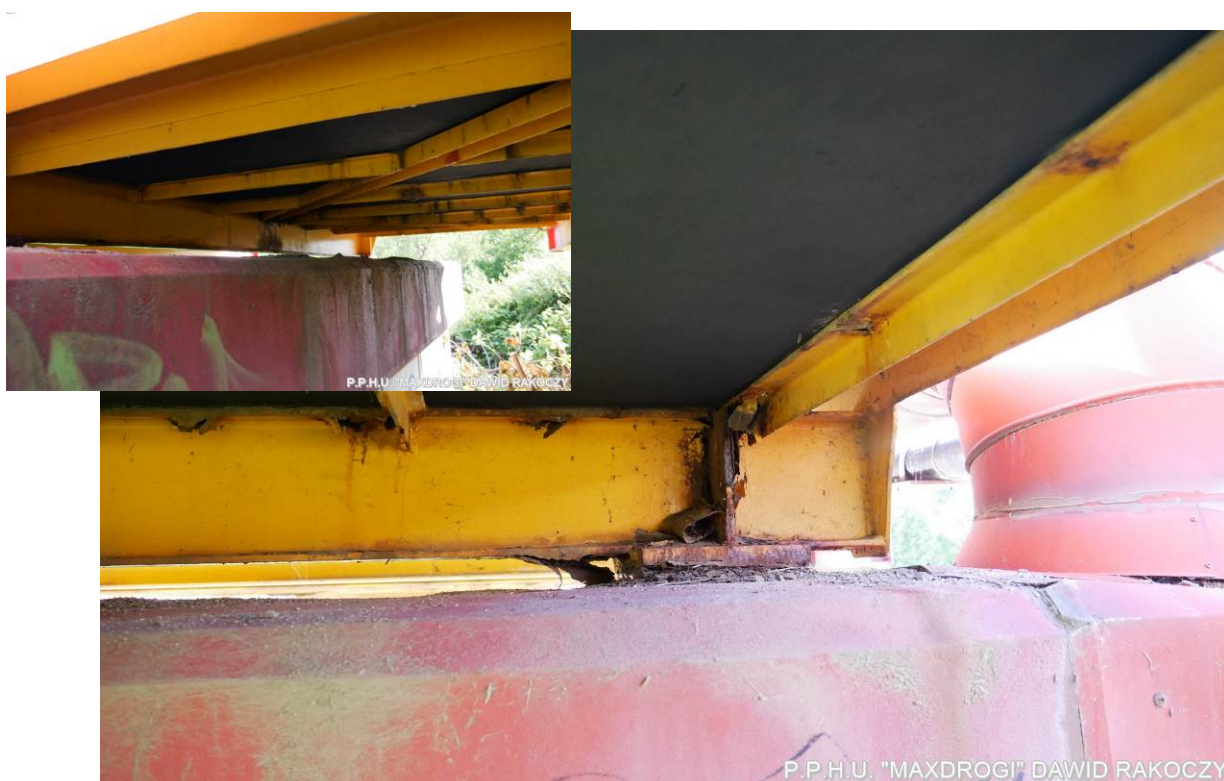
Fot. 12. Obszerna korozja podporowych stalowych łożysk stycznych oraz zanieczyszczenia warstwą gruntu na ławach podłożyskowych podpór
