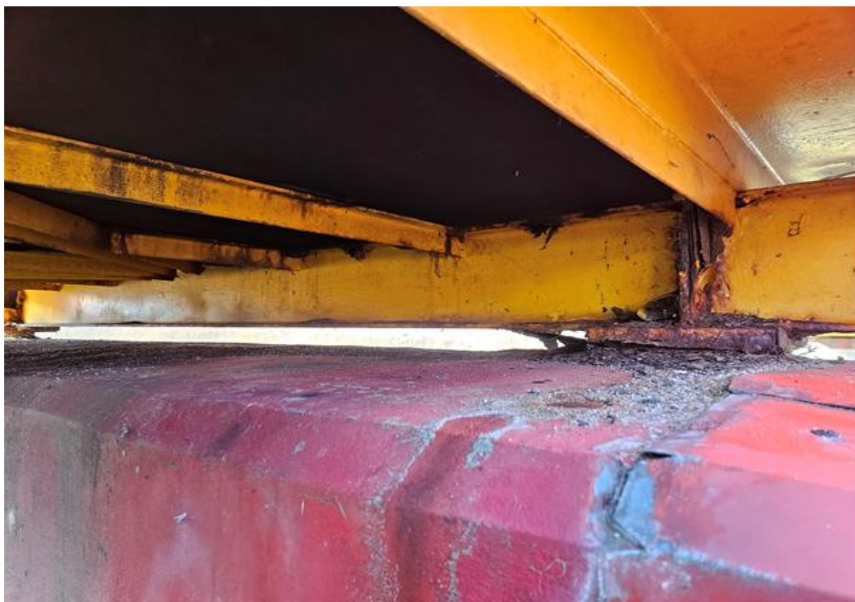
Korozja podporowych stalowych łożysk stycznych oraz zanieczyszczenia warstwą piasku na ławach podłożyskowych podpór
