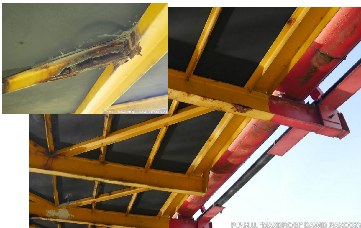
Fot. 11. Niszczenie zabezpieczeń antykorozyjnych i lokalne ogniska korozji obejmują dźwigary stalowe, poprzecznice, stężenia i podłużnice oraz stalowe osłony i wsporniki sieci urządzeń obcych
